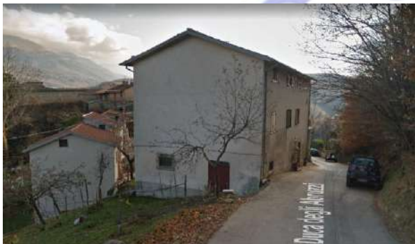
Foto 1 – Stato ante Sisma 2016
