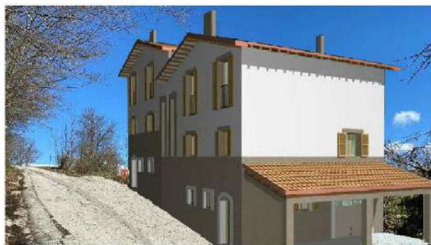
Foto 2 – Stato ante Sisma 2016
