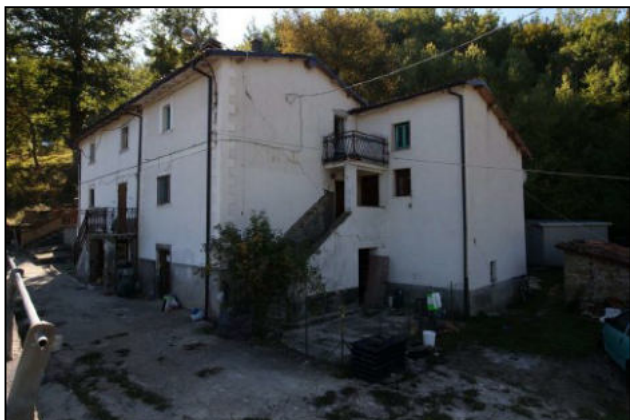
Foto ante ordinanza demolizione
