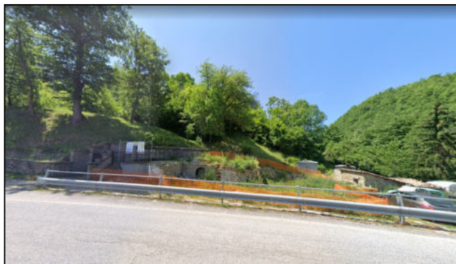
Foto post ordinanza demolizione
