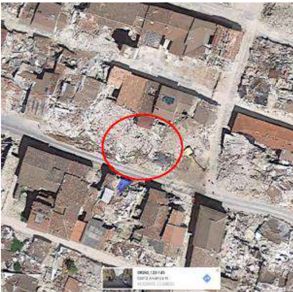
Vista esterna negozio post sisma
