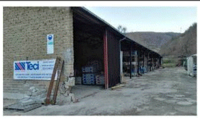
Vista esterna dell'edificio danneggiato
