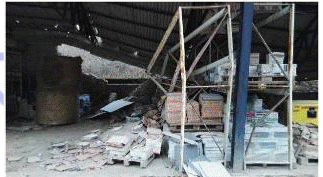
Vista esterna edificio danneggiato
