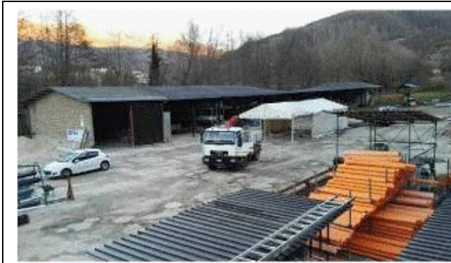
Vista dell'area antistante l'edificio danneggiato
