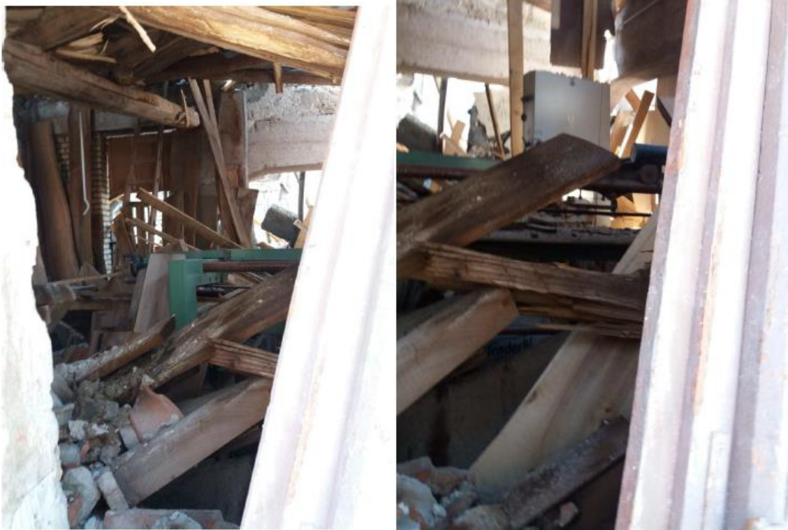
Documentazione fotografica dell'edificio danneggiato dal sisma (piano primo soppalcato)
